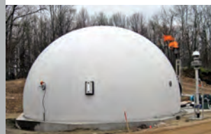
Ultrastore membrane gasholders from Ovivo USA
